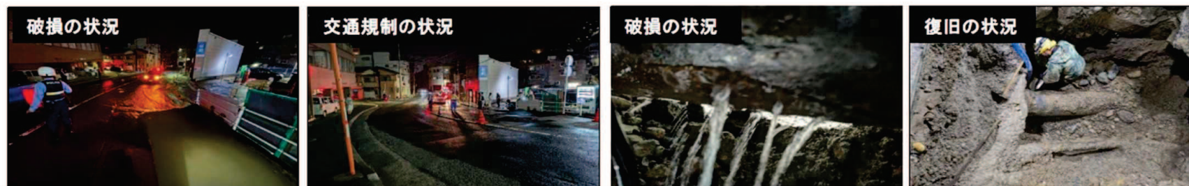
図 管路の破損による漏水事故の状況 (長崎県長崎市)
