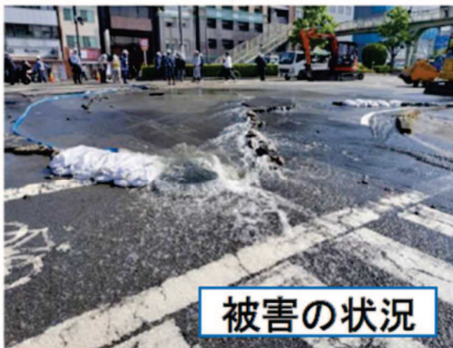
図 管路の破損による漏水事故の例 (京都府京都市下京区)
