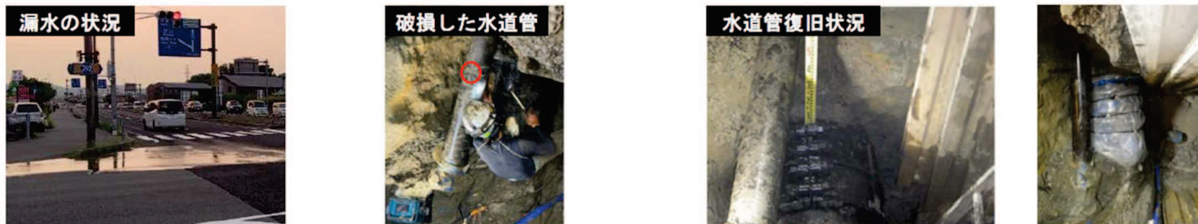
図 管路の破損による漏水事故の状況 (鳥取県鳥取市)
