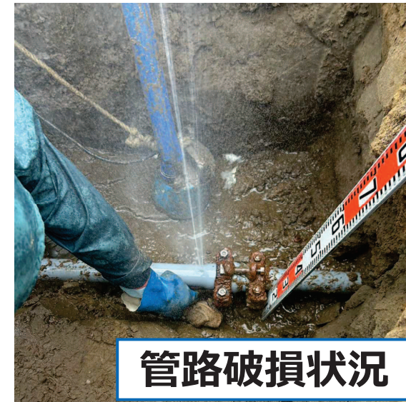
図 50mm塩化ビニル管破損状況 (R7長生広域水道 長生村宮成地先)
