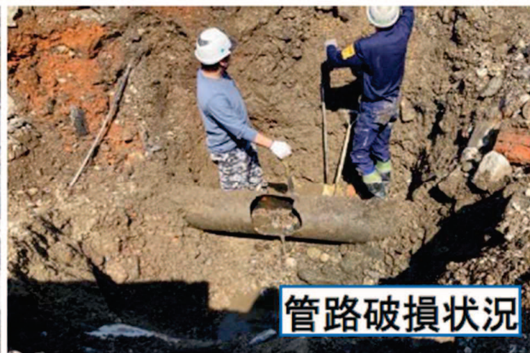
図 管路の破損による漏水事故の例 (京都府京都市下京区)
