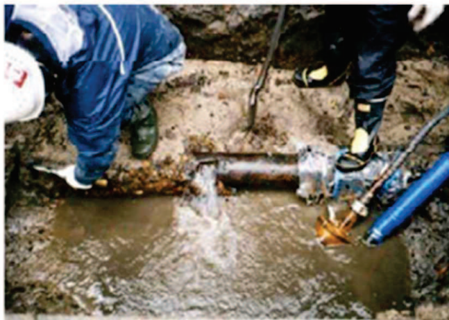
図 管路の破損による漏水事故の例 (京都府京都市下京区)
