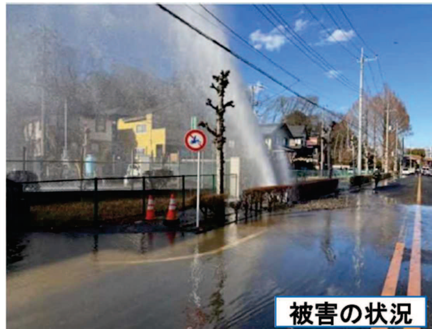
図 管路の破損による漏水事故の例（埼玉県所沢市）
