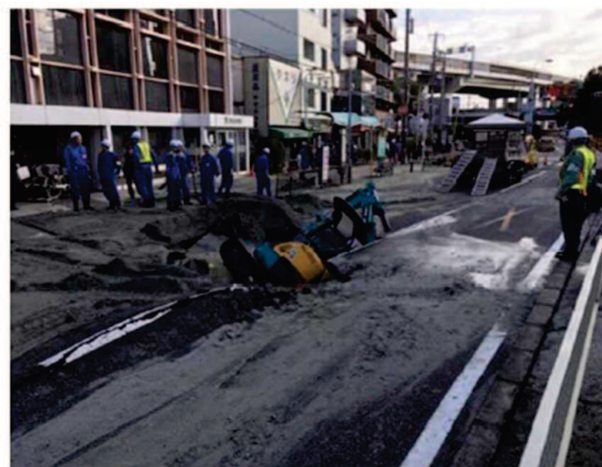
図 管路の破損による漏水事故の例 (京都府京都市下京区)
