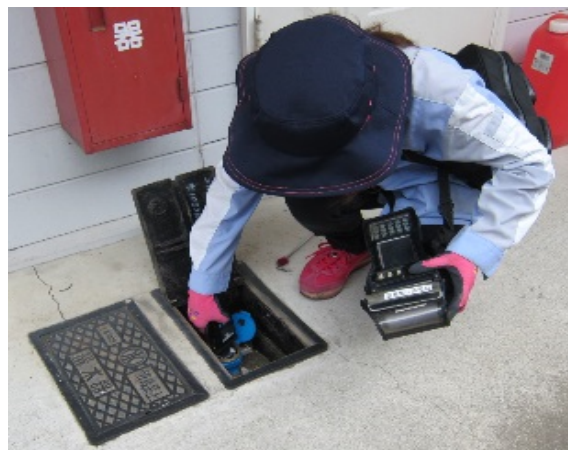
漏水調査の様子
